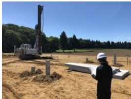
施工管理実習
