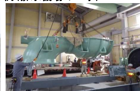
ポンプ設備の据付
